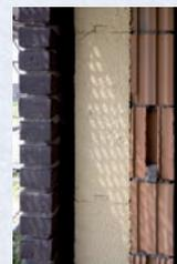
**Le polystyrène expansé (PSE)** : ce matériau sous forme de panneaux est essentiellement utilisé en isolation de façade par l'extérieur avec une finition en crépis. On le trouve également en sacs de billes pour d'autres utilisations.
